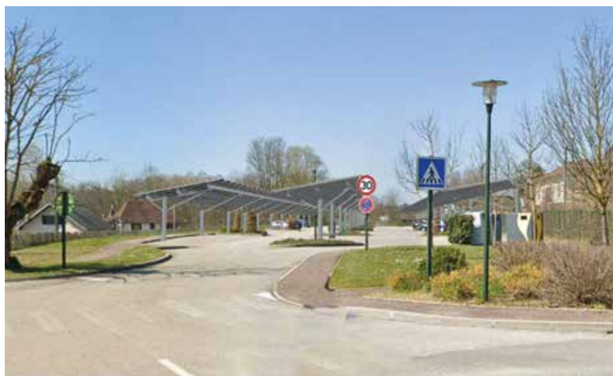
Le parking après les travaux
